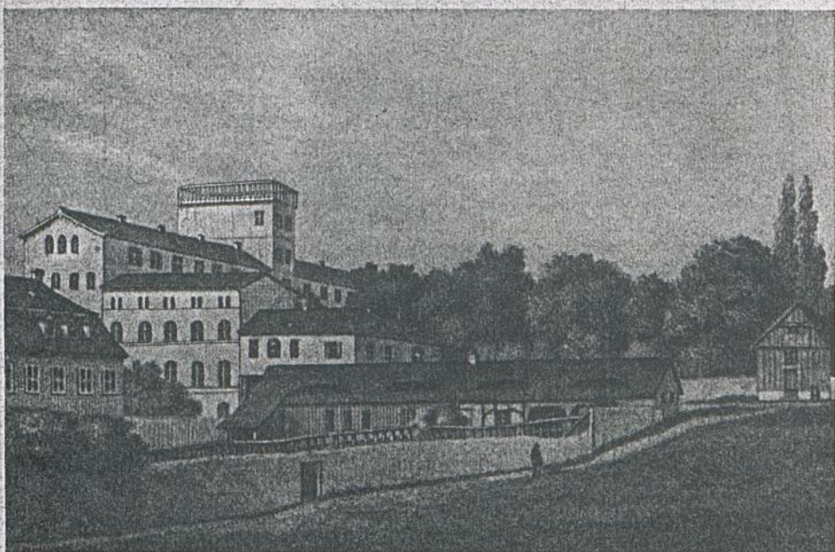
Blick vom Jubiläumsgarten auf Verwaltung (links), Pädagogium (Mitte), das Niemeyer'sche Gartenhaus (H.-Heim), Turnhalle III „Ruhstall“ (ganz rechts) und Bauhof (Vordergrund) aus dem Jahre 1863
