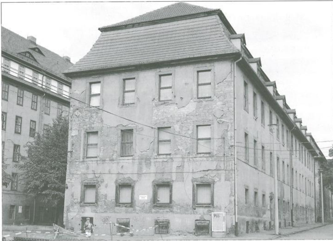
Die ehemalige Cansteinsche Bibelanstalt im heutigen Zustand.
